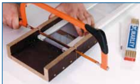
Corte de los perfiles a la medida necesaria.
