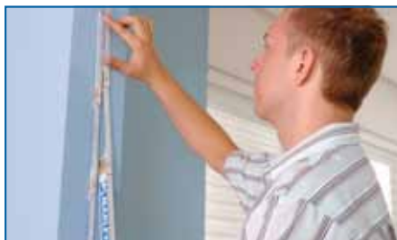
Medición de la abertura (ancho y altura)
