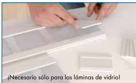
Fijar las molduras en la parte inferior cortada de las láminas de vidrio utilizando cinta adhesiva de doble contacto.
